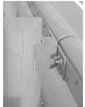
Poste y viga de maderaA
