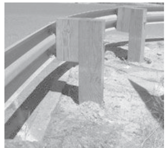
Poste de madera y valla metálica
